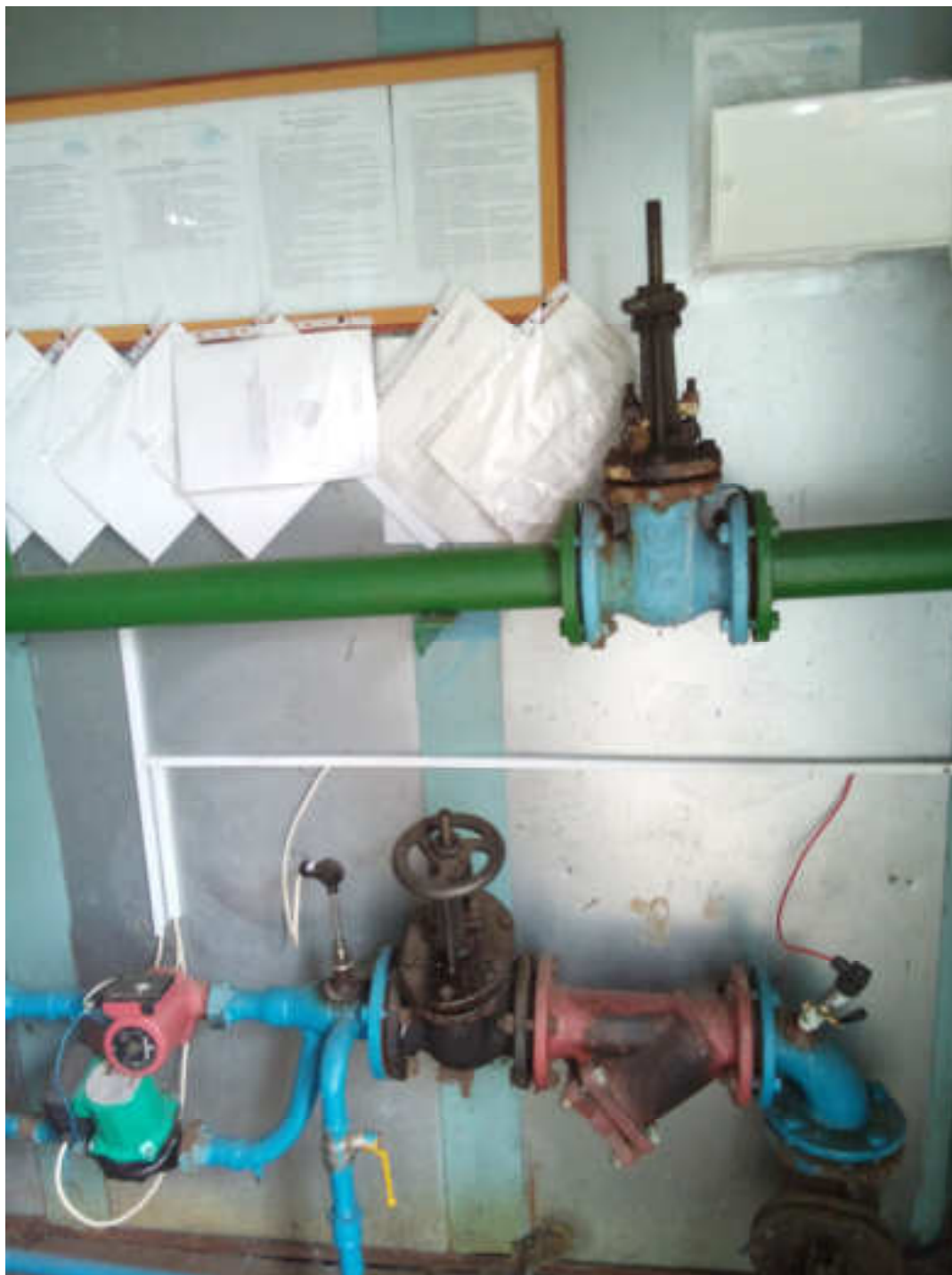
Видимое изображение №2 Обвязка насосов
